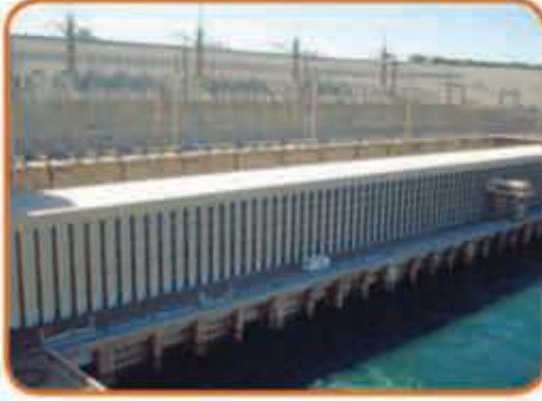
محطة السد العالي لتوليد الكهرباء
