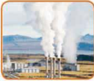
محطة غاز طبيعي
